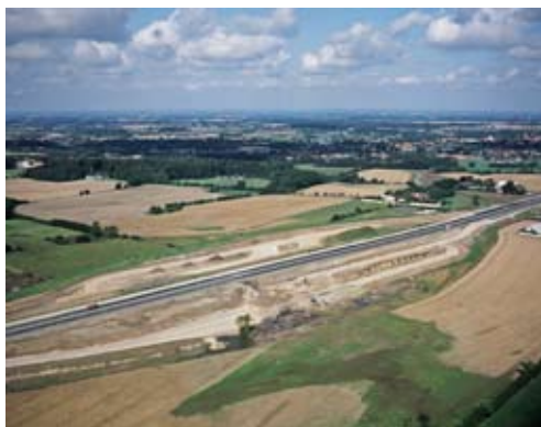
Rastepladsen ved Groven/Dynden under anlæg
