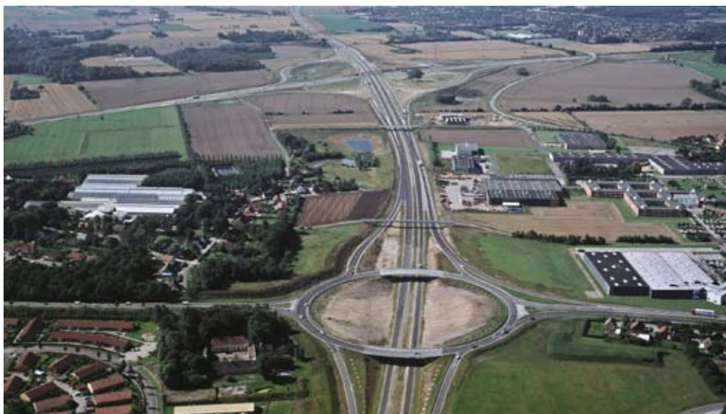
Det færdige motorvejsanlæg set fra Odense mod Kværndrup
