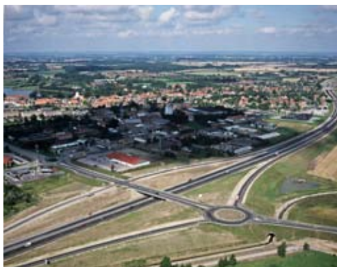
Tilslutningsanlæg ved Ørbækvej
