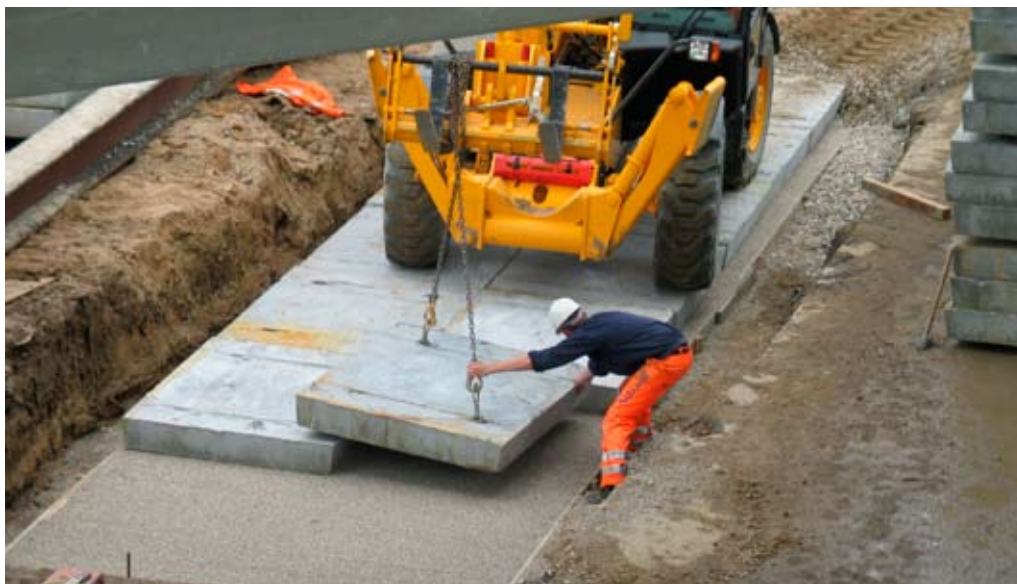
Præfabrikerede fundamentsplader lægges klar, så broen kan skubbes på plads
