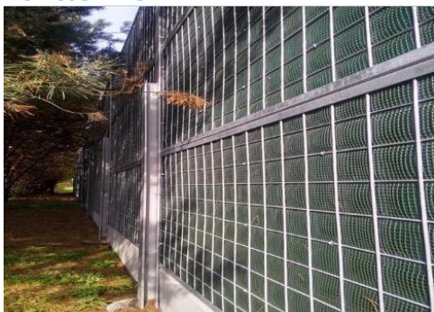
Støjskærm til beplantning (før beplantning er etableret)
