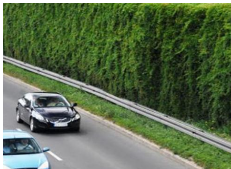
Støjskærm til beplantning (med beplantning etableret)
