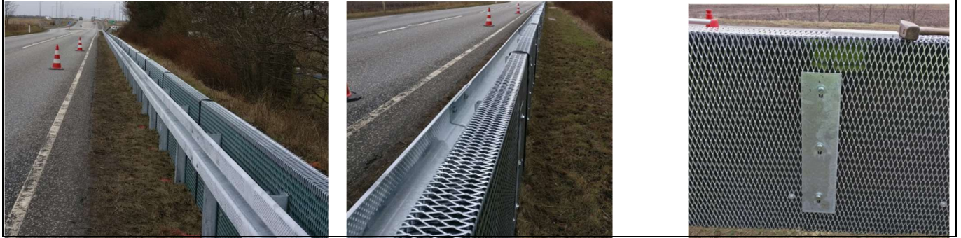
Støjdæmpende autoværn rute 15 ved Pårup
