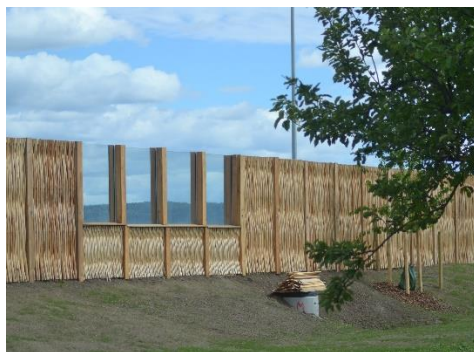
Støjskærm med afbarket pilefacade og transparent felt
